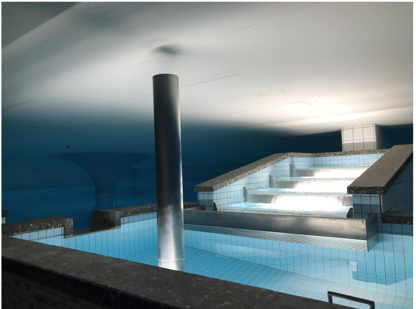
Blick ins Wasserreservoir Moosberg
