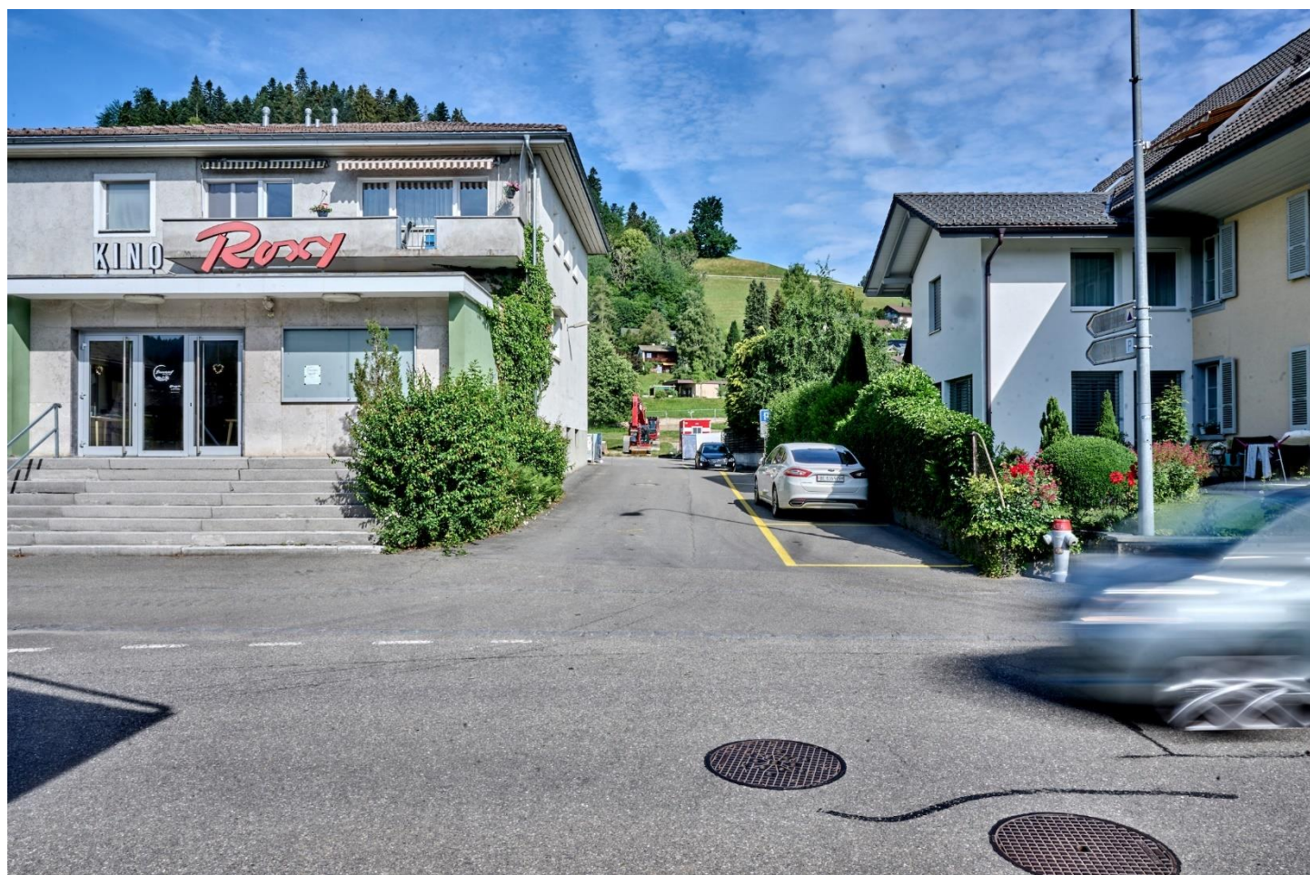
Ehemaliges Kino Roxy, Dorfstrasse 32 in Signau
